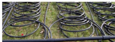
configurazione sonde geotermiche (tubi in PE)
